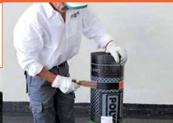
**1** - Trattare con primer bituminoso (POLYPRIMER HP 45 Professional) la superficie da impermeabilizzare.
